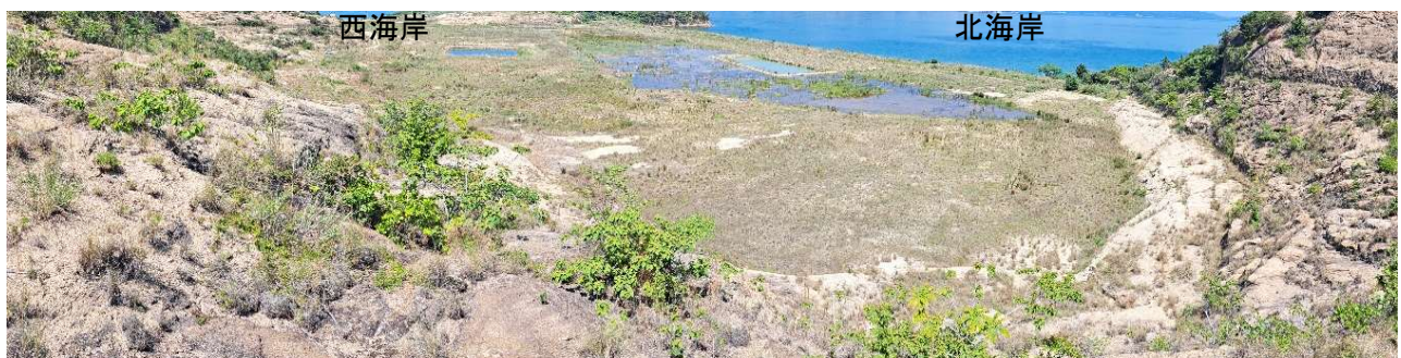
写真 1 豊島処分地（東側から撮影）
