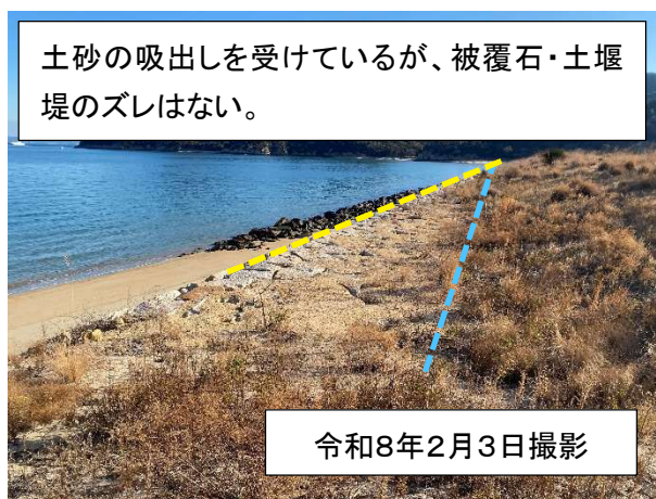
写真5 土堰堤（被覆石の法線を基準に、土堰堤の法尻法線を目視にて定点観測：変状なし）
