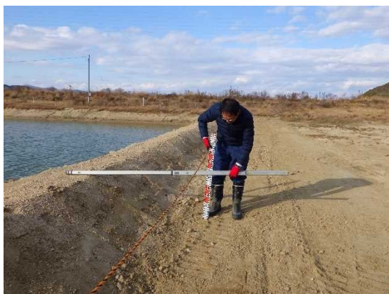
写真4 浸透池⑯の嵩上げ高さの確認
