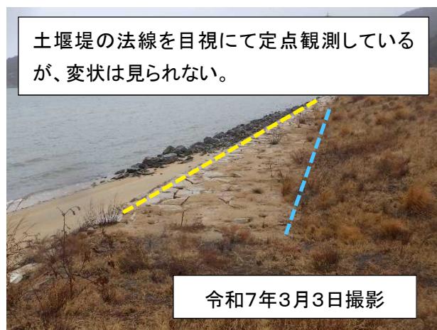
写真6 土堰堤（被覆石の法線を基準に、土堰堤の法尻法線を目視にて定点観測：変状なし）
