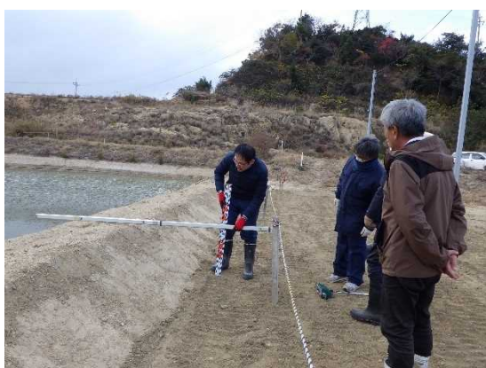
写真8 浸透池D西の嵩上げ高さの確認
