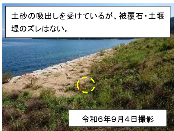
写真6 土堰堤（土砂の吸出し状況：本堤への影響なし）
