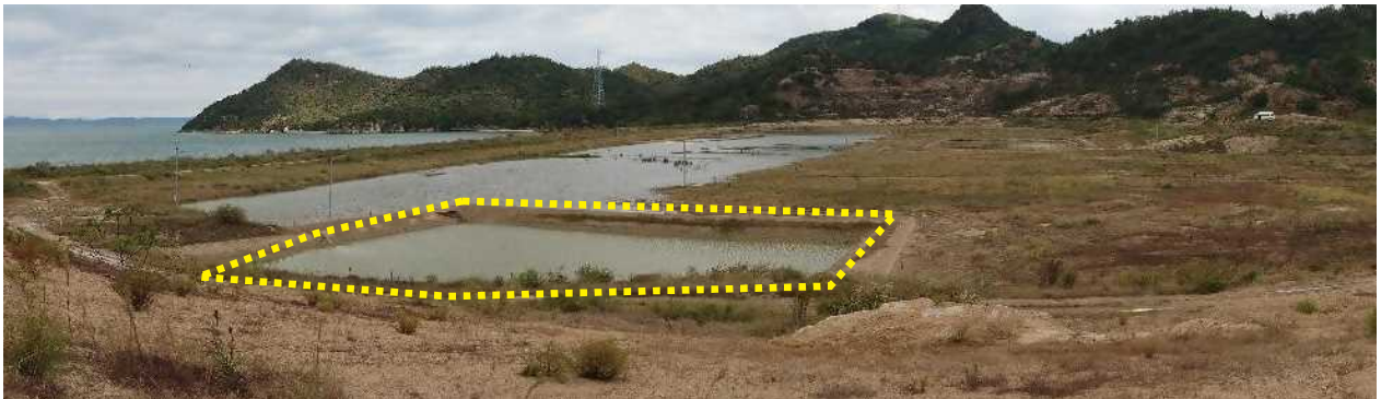
写真 3 浸透池D西の周辺状況 (R06.11.5 北西側から撮影)
