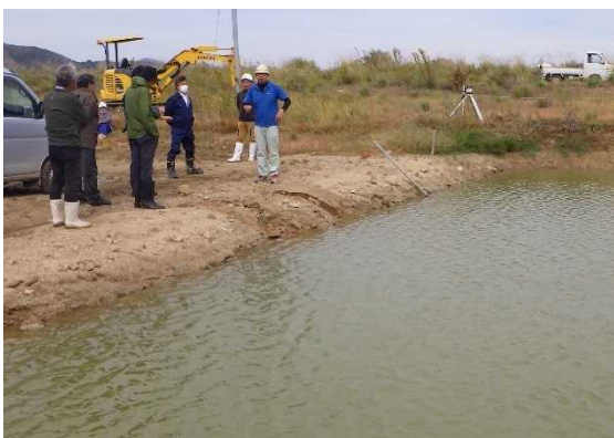
写真 1 工事中の浸透池①⑥の視察
