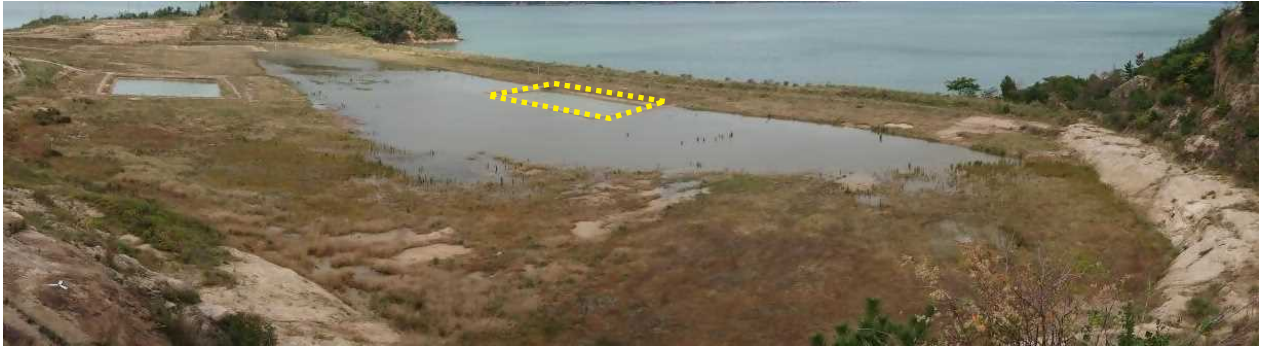
写真 1 浸透池⑯の周辺状況 (R06.11.5 東側から撮影)
