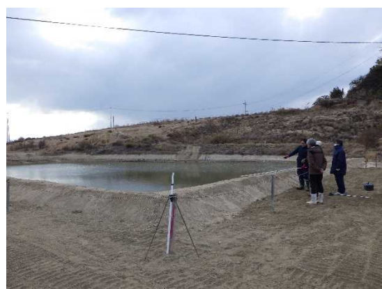
写真9 完了確認時の浸透池D西の状況
