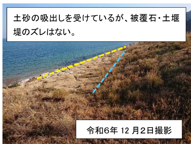
写真6 土堰堤（被覆石の法線を基準に、土堰堤の法尻法線を目視にて定点観測：変状なし）
