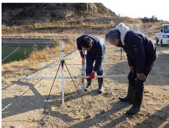
写真6 浸透池⑮の嵩上げ高さの確認
