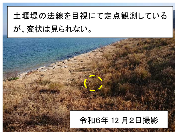
写真6 土堰堤（土砂の吸出し状況：本堤への影響なし）
