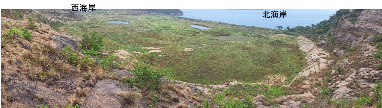
写真 1 豊島処分地（東側から撮影）
