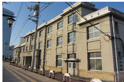
解体直前に撮影された高松港管理事務所 (平成24年 撮影)
