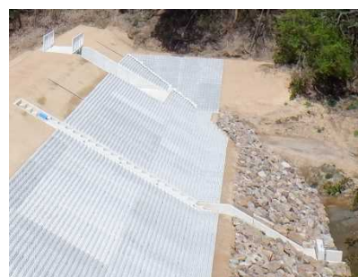
▲工事で発生した石材を法面保護材に再利用
