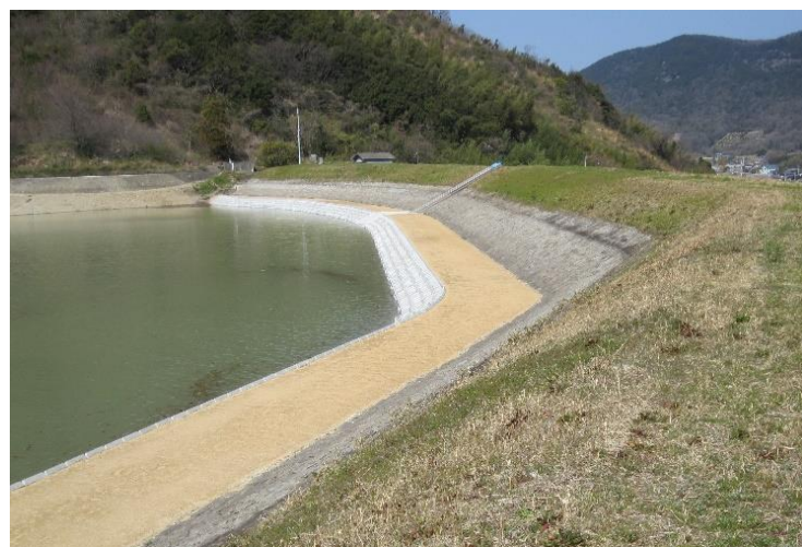
【ため池の耐震補強工事】
