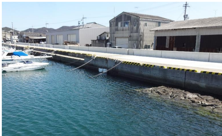
【地震・津波対策工事】
