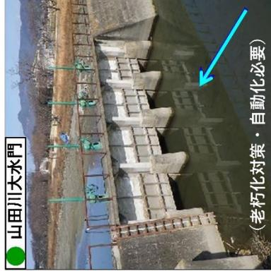
● 相引川排水樋管(門) (老朽化対策・自動化必要)
