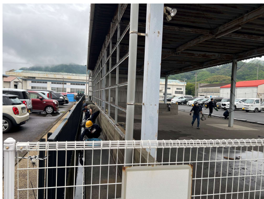
4 月 30 日 側溝清掃
