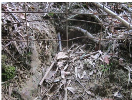
写真3 裾部分の掘り返し（補修前）
