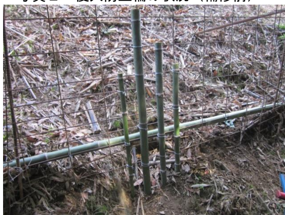
写真4 侵入防止柵の補修状況（補修後）
