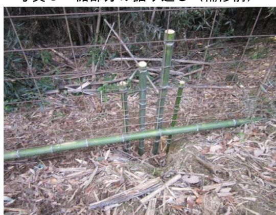
写真5 補修状況（カンキツ園側）
