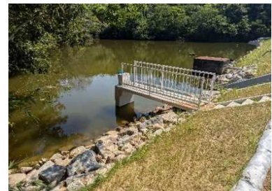
▲工事で発生した石材を法面保護材に再利用
