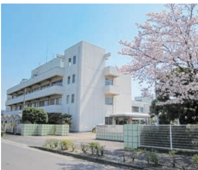
香川県立丸亀病院
