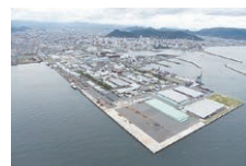
▲高松港国際物流ターミナルの整備
