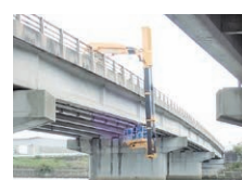
▲橋梁点検状況(新川尻橋)
