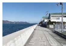
▲地震・津波対策工事(志度港)
