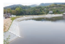
▲老朽ため池整備工事
