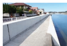
▲地震・津波対策工事(相引川)
