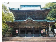
▲重要文化財・金刀比羅宮の主要建造物の大規模保存修理
