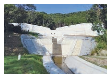
▲岩崎川砂防堰堤(普通寺市大麻町)
