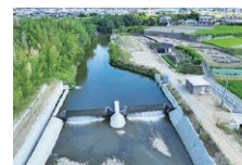
▲本津川広域河川改修工事(高松市鬼無町・御蔵町)
