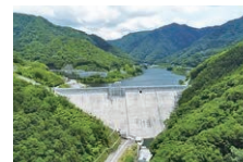
▲試験湛水時の梶川(かがわ)ダム(高松市塩江町)
