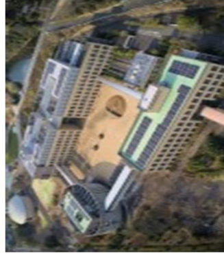
重点対策加速化事業の補助金を活用した、県有施設への再エネ導入
