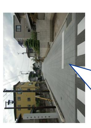
石畳舗装により、速度抑制効果
