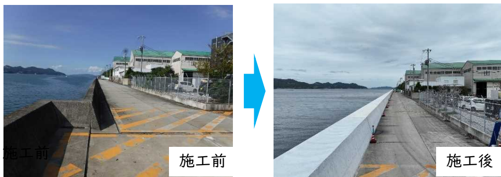
対策工事施工前後の写真
