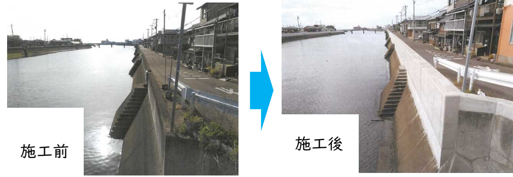
対策工事施工前後の写真
