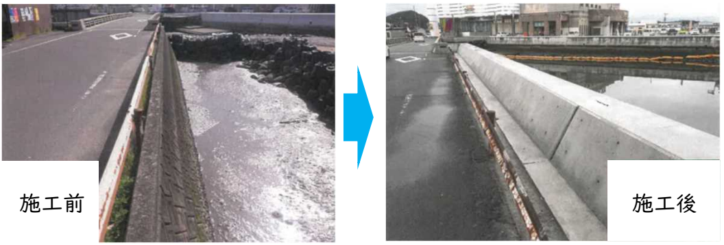
対策工事施工前後の写真
