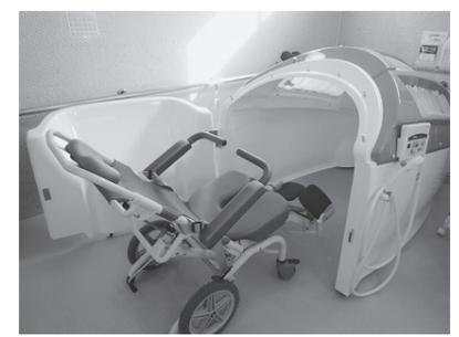
**南棟** R4年6月21日に東棟浴室改修工事が始まり、R4年9月16日に工事が終了しました。工事の内容は東棟浴室の床タイルを滑りにくいクッション素材に変更すること、シャワーを新しくすること、そして機械浴を設置することでした。東棟南エリア浴室にR4年11月14日機械浴が設置されました。利用者の方々が安全に入浴支援を受けられるようにとの職員の思いが4年越しで実現されました。長い施設生活で車椅子が主な移動手段になったり、深いタイル張りの浴槽(タイルの階段3段使用で出入りする)での入浴が難しくなった利用者さんが機械浴で安心安全に入浴できるようになりました。
