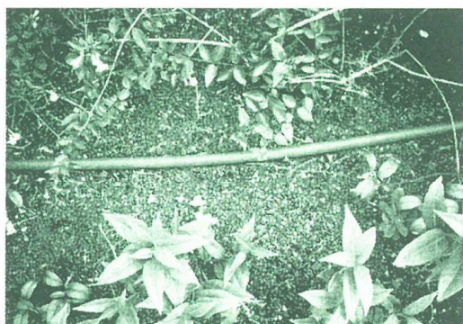
しみ出しパイプ（国土交通省屋上）
