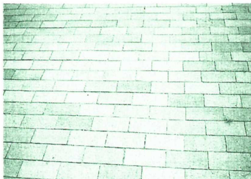
コート紙の製造で発生する粘土を焼成して作られたレンガ
