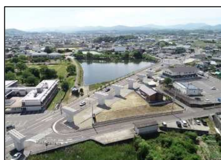
香南工区 現在整備区間
