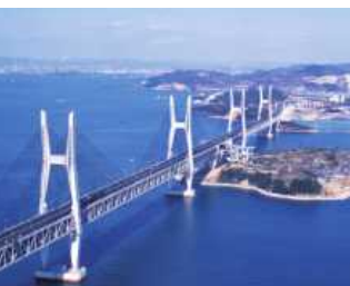
瀬戸大橋 Seto Ohashi Bridge
