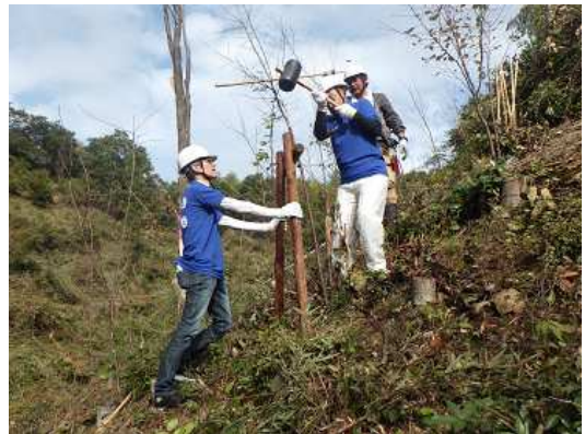
二脚鳥居を採用しました。山側に立ち、ゴムの掛矢を使ってしっかりと打ち込みます。
