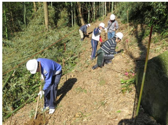
<斜面での作業は大変です>
