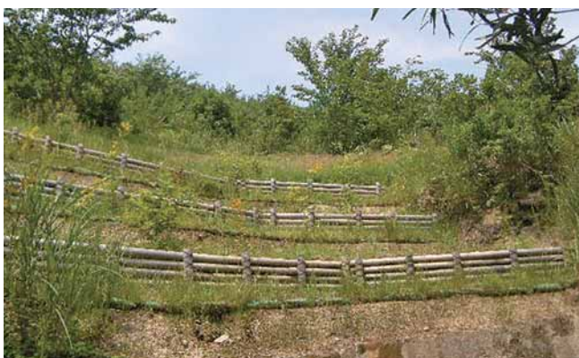
平成 21 年度森林荒廃地緊急整備事業（丸太柵工）
