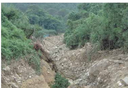
台風21号の被災状況（観音寺市）
