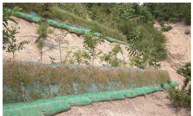
平成 22 年度森林荒廃地緊急整備事業（金網筋工）
