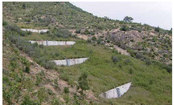
平成 19 年度予防治山事業（土留工等）
