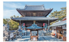
▲重要文化財・普通寺金堂の防災施設整備
