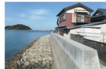
▲地震・津波対策工事(引田海岸)
