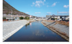
▲大東川広域河川改修工事(丸亀市飯山町)
