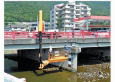
▲橋梁点検状況(北山大橋)
