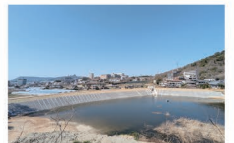
▲老朽ため池整備工事
