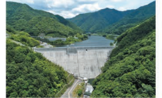
▲試験湛水中の柵川(かがわ)ダム(高松市塩江町)
