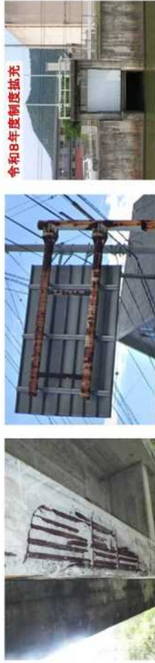
鉄筋が露出している橋梁の補修が必要 腐食が進行している標識柱等の更新が必要 小規模水門の老朽化対策等が必要
