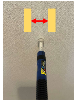
③付箋と付箋の間を下地探しピンで刺す。
