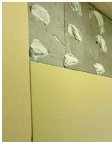
③コンクリート（GL工法）
