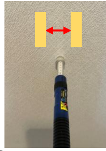
③付箋と付箋の間を下地探しピンで刺す。
