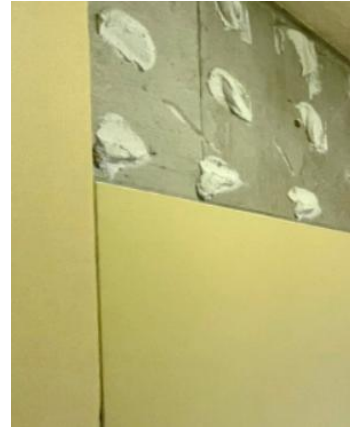
③コンクリート（GL工法）
