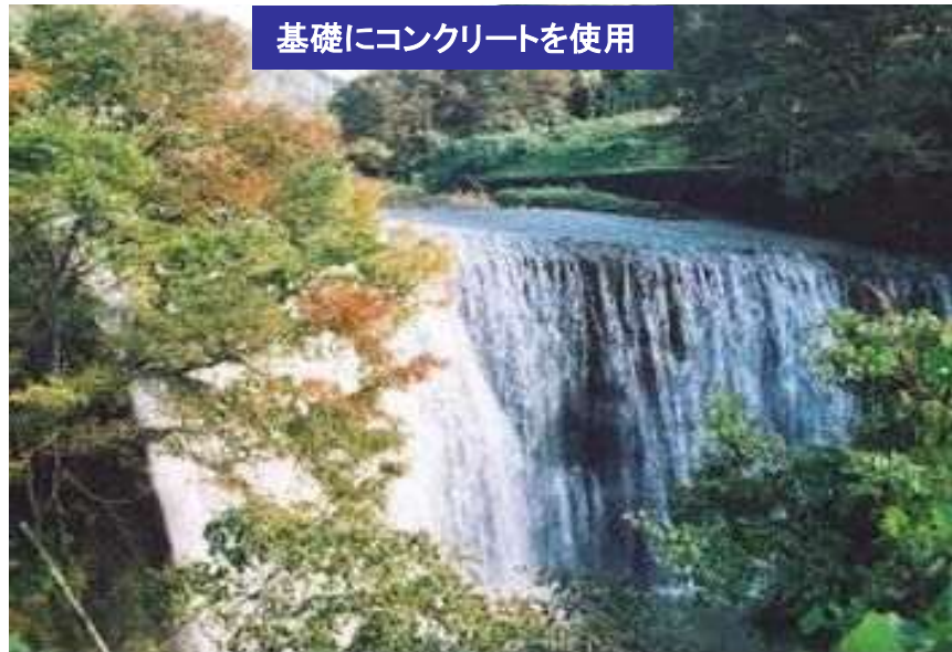
【山梨県】勝沼砂防堰堤（大正4年～大正6年）
