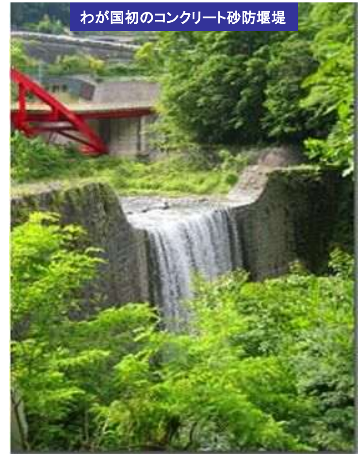
【山梨県】芦安堰堤（大正5年～大正15年）
