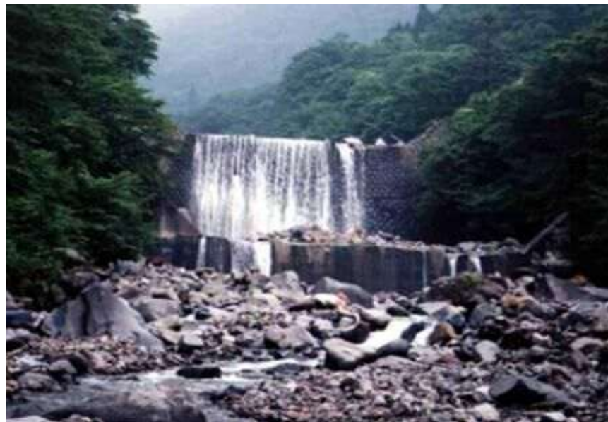
【栃木県】稲荷川砂防堰堤群（大正9年～昭和12年）
