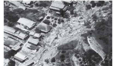
(旧内海町岩ヶ谷地区上空より空撮)
