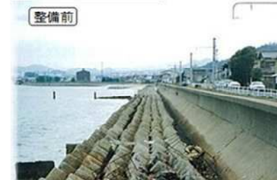
護岸の補強(原浜海岸)
