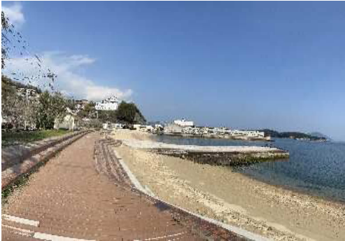
侵食ランク B 【土庄東港海岸（土庄町）】
