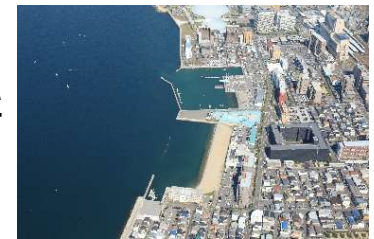
＜高松港海岸：西浜地区＞
