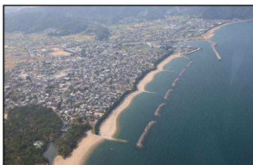
津田港海岸(琴林地区) (侵食対策事業)
