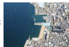
<高松港海岸:西浜地区>
