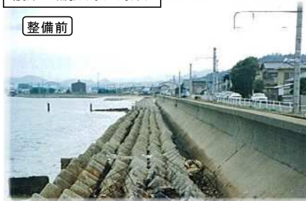
護岸の補強(原浜海岸)
