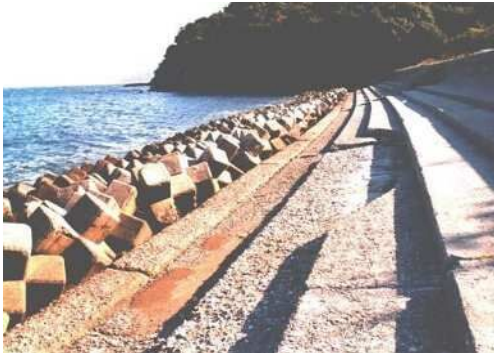
施設ランク A（整備前）【坂元海岸（東かがわ市）】
