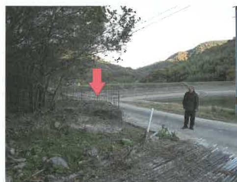
亀割池周辺にのこされている崩落した岩(矢印は筆者による) 後方は亀割池
