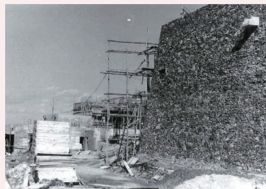
第1展示室外壁工事の記録写真
