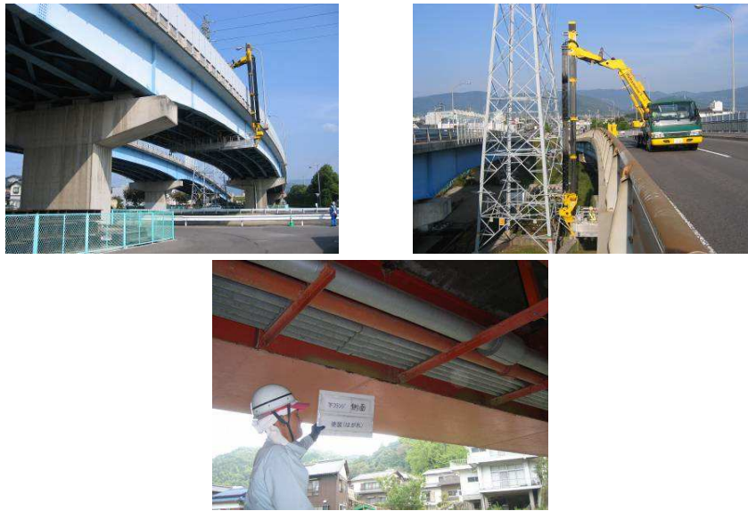
図 4.1 定期点検の様子
