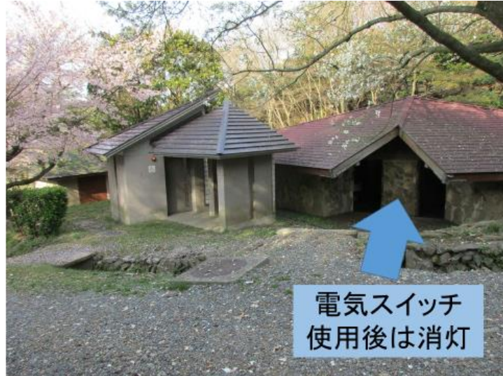
第2炊事場 下トイレ 多目的トイレ
